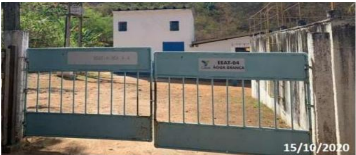
Figura 25 – EEAT-04 de Água Branca Fonte: ARSAL, 2020
