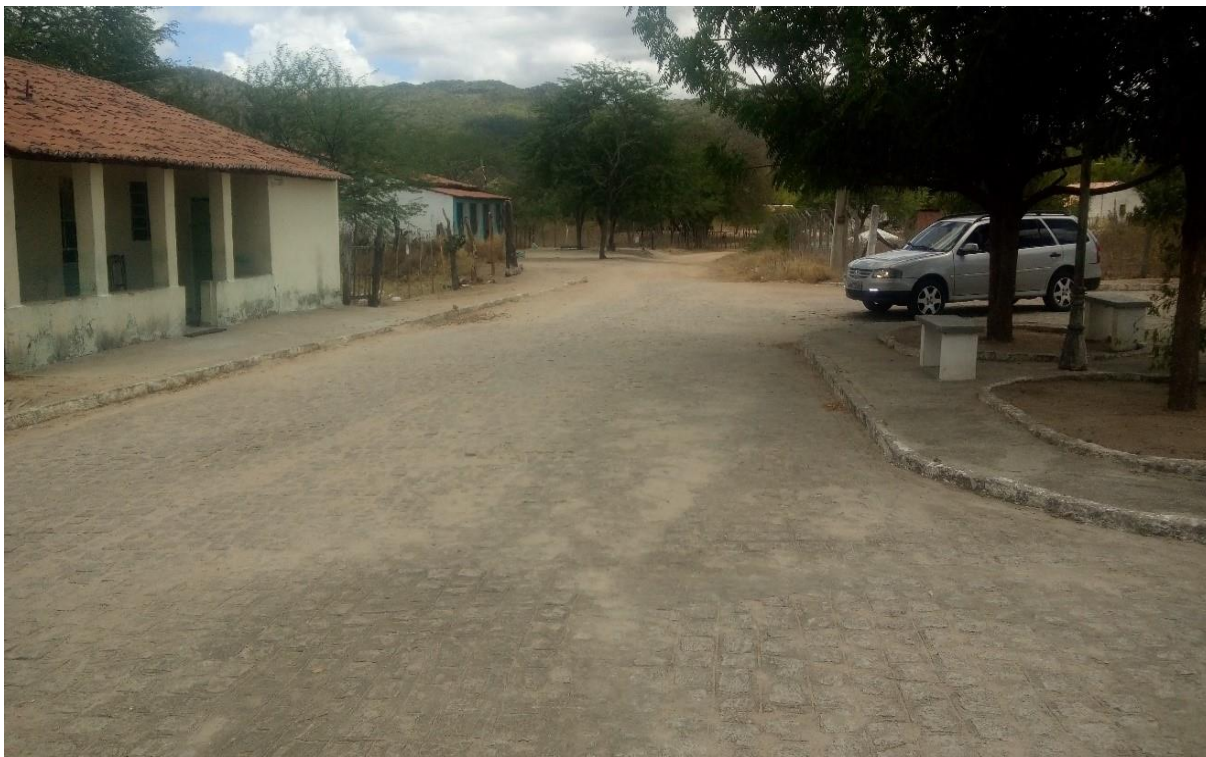
Figura 155 – Rua Pavimentada com Paralelepípedo na Comunidade Conceição Fonte: INSTITUTO GESOIS, 2021.
