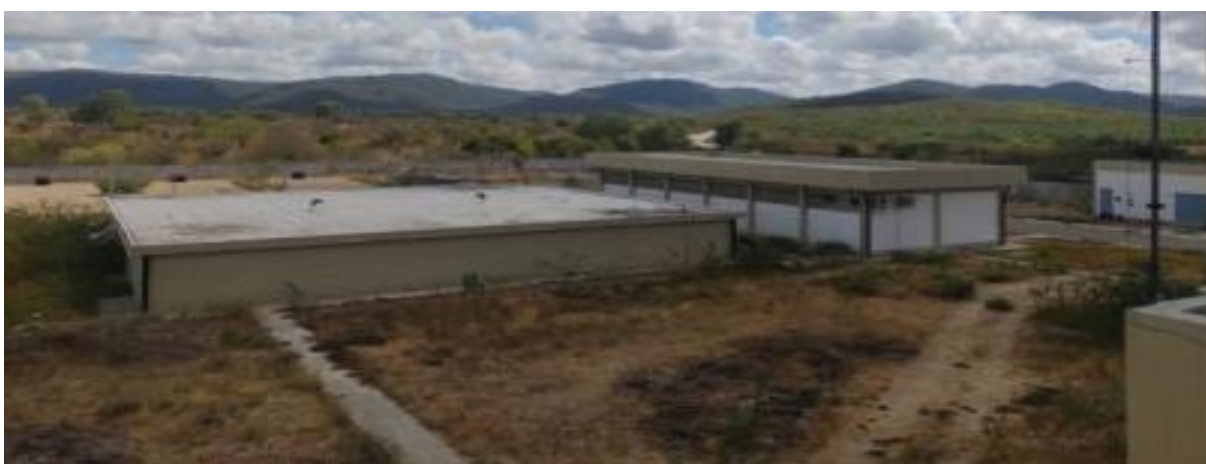
Figura 24 – Reservatório Apoiado da ETA de Água Branca Fonte: INSTITUTO GESOIS, 2021.
