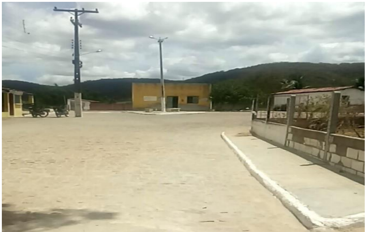
Figura 149 – Pavimentação Poliédrica na Região Central do Distrito Papa Terra Fonte: INSTITUTO GESOIS, 2020.
