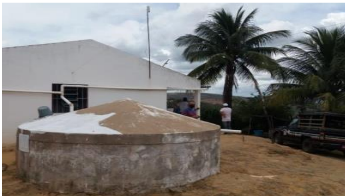
Figura 126 – Cisterna Localidade Casa Nova Fonte: INSTITUTO GESOIS, 2021.
