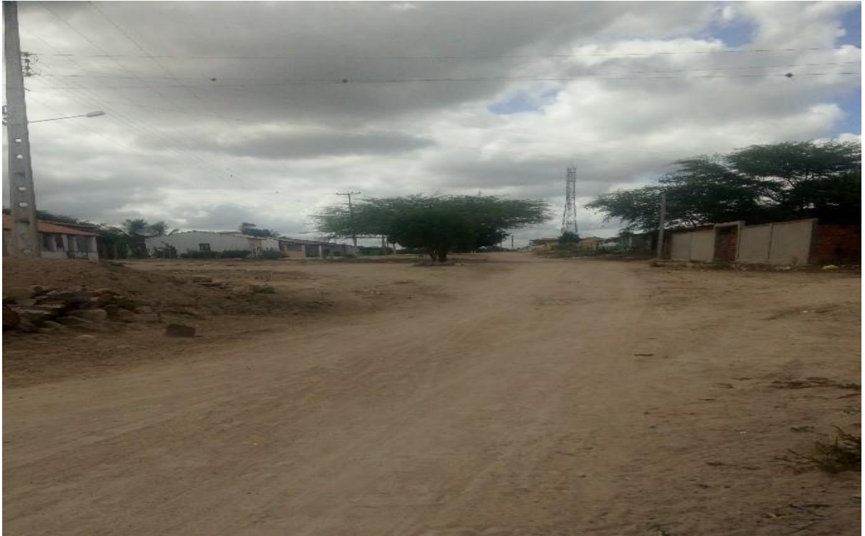
Figura 148 – Acesso sem Pavimentação ao Distrito Lagos das Pedras Fonte: INSTITUTO GESOIS, 2020.
