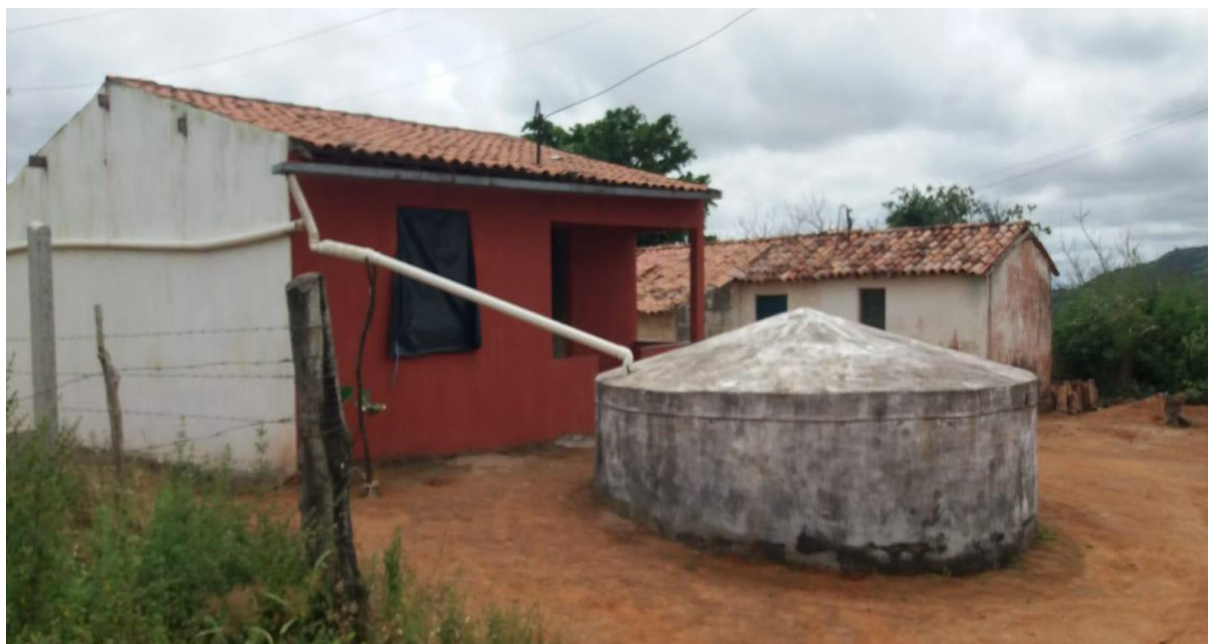
Figura 66 – Cisterna para Captação de Água da Chuva e Armazenamento de Água Trazida por Carro Pipa Localidade Tamandaré
