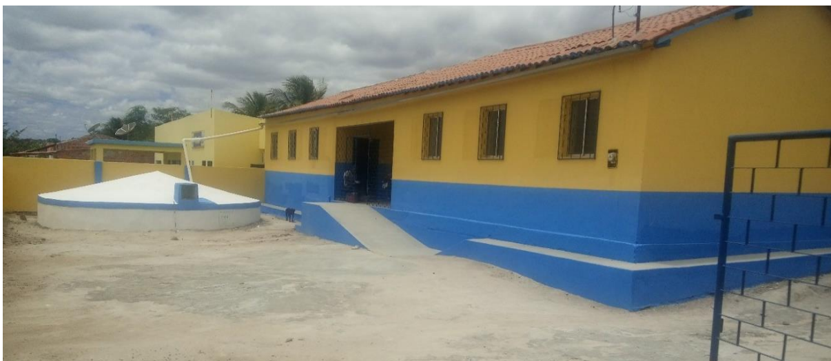
Figura 74 – Cisterna para Captação de Água de Chuva e Armazenamento de Água Trazida por Carro-Pipa na Comunidade de Quixabeira Fonte: INSTITUTO GESOIS, 2021.
