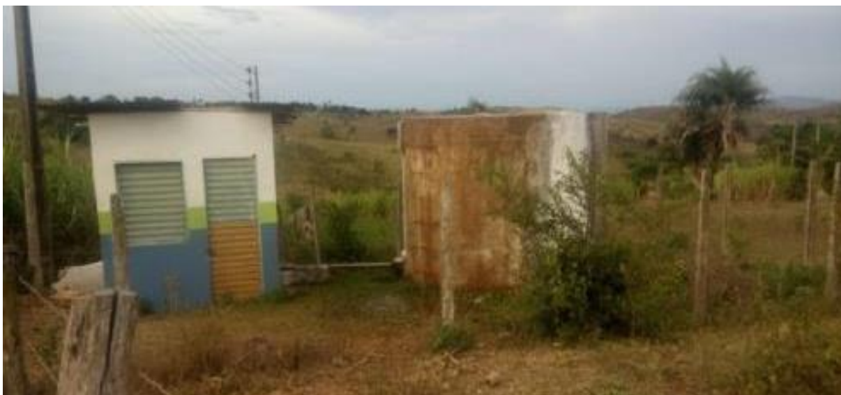
Figura 59 – Captação Sítio Batuque Fonte: INSTITUTO GESOIS, 2021.
