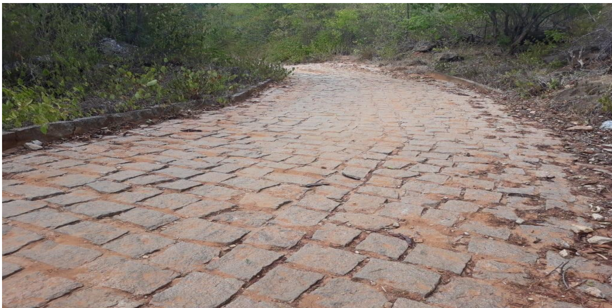
Figura 157 – Estrada que dá Acesso à Comunidade Serra do Paraíso Pavimentada
