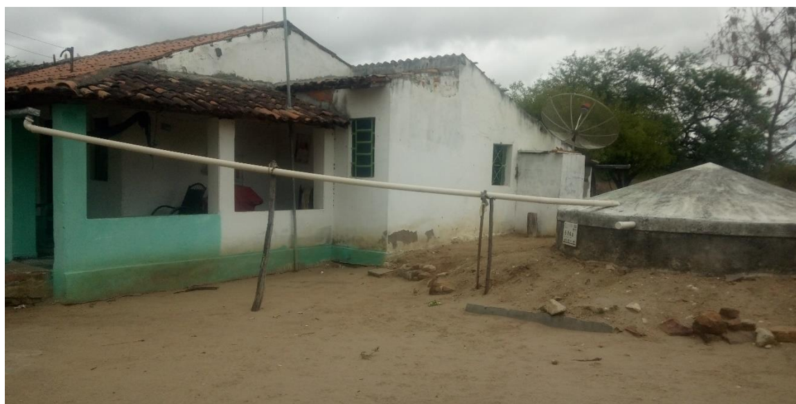
Figura 107 – Sistema de Captação da Água da Chuva na Comunidade Lagoa do Padre
