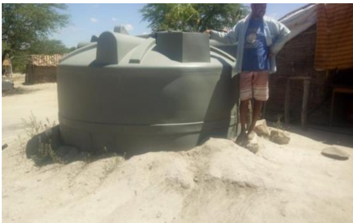
Figura 80 – Cisterna Localidade Salina
