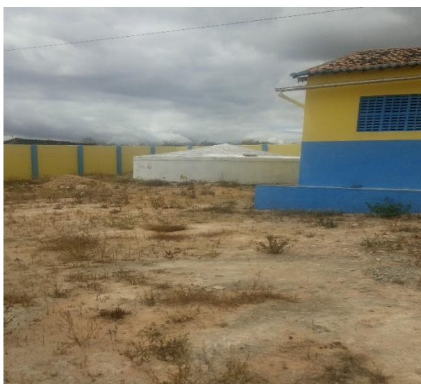
Figura 109 – Cisterna para Captação de Água da Chuva e Armazenamento de Água Trazida por Carro-Pipa na Comunidade Mandacaru
