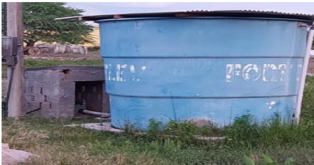
Figura 54 – Caixa D'água Distrito Localidade Alto dos Coelhos Fonte: INSTITUTO GESOIS, 2021.
