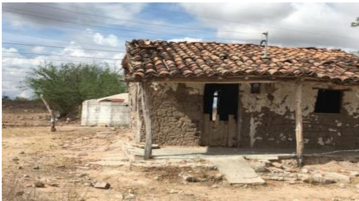
Figura 82 – Cisterna Localidade Pião Fonte: INSTITUTO GESOIS, 2021.
