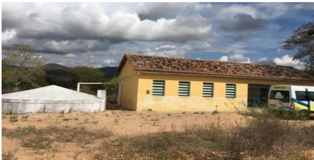
Figura 83 – Escola Municipal e Cisterna Localidade Matinha Fonte: INSTITUTO GESOIS, 2021.
