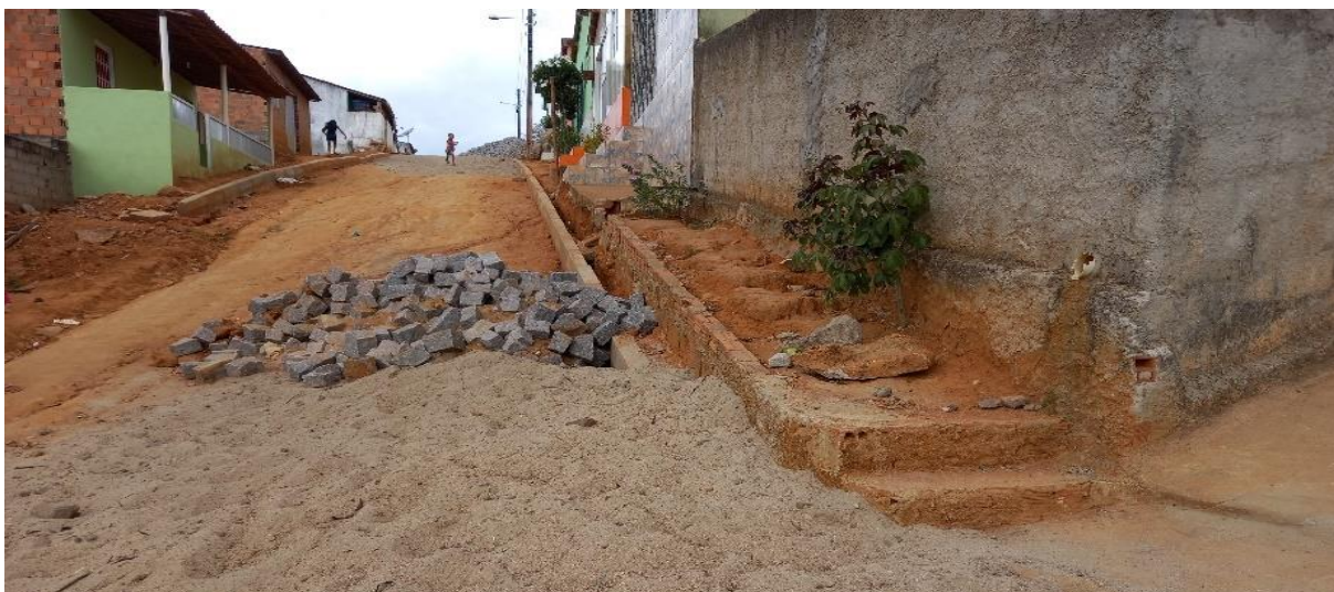
Figura 144 – Pavimentação Rua Enoque Gomes em Água Branca Fonte: INSTITUTO GESOIS, 2020.
