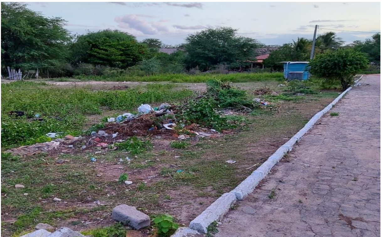
Figura 147 – Calçamento sem a Presença de Sarjetas no Distrito Alto dos Coelhos Fonte: INSTITUTO GESOIS, 2020.
