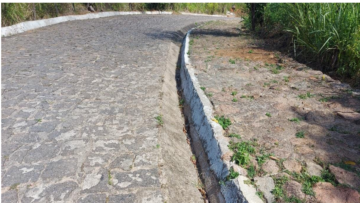
Figura 143 – Pavimentação Poliédrica e Sarjeta em Rua Localizada no Mirante do Calvário Fonte: INSTITUTO GESOIS, 2020.
