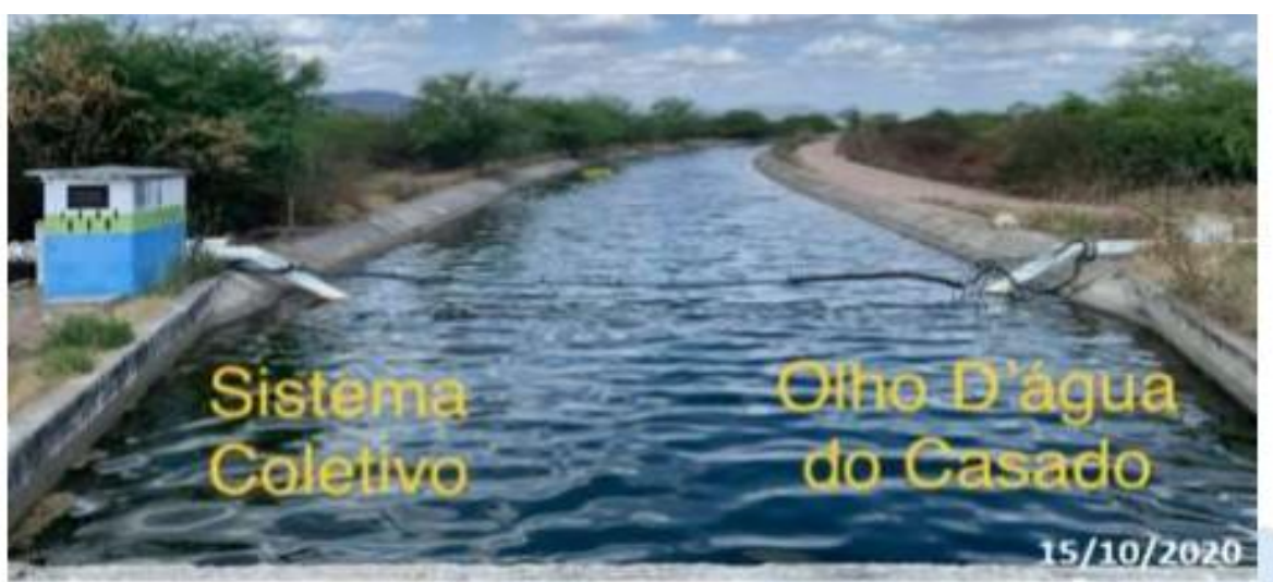
Figura 21 – Captação no Canal do Sertão Fonte: ARSAL, 2020.
