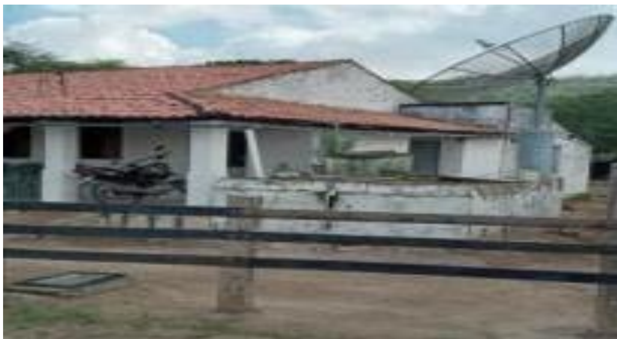
Figura 43 – Caixa Coletora de Água de Chuvas e Pipas Localidade de Moreira de Cimas/Malhada das Pedras
