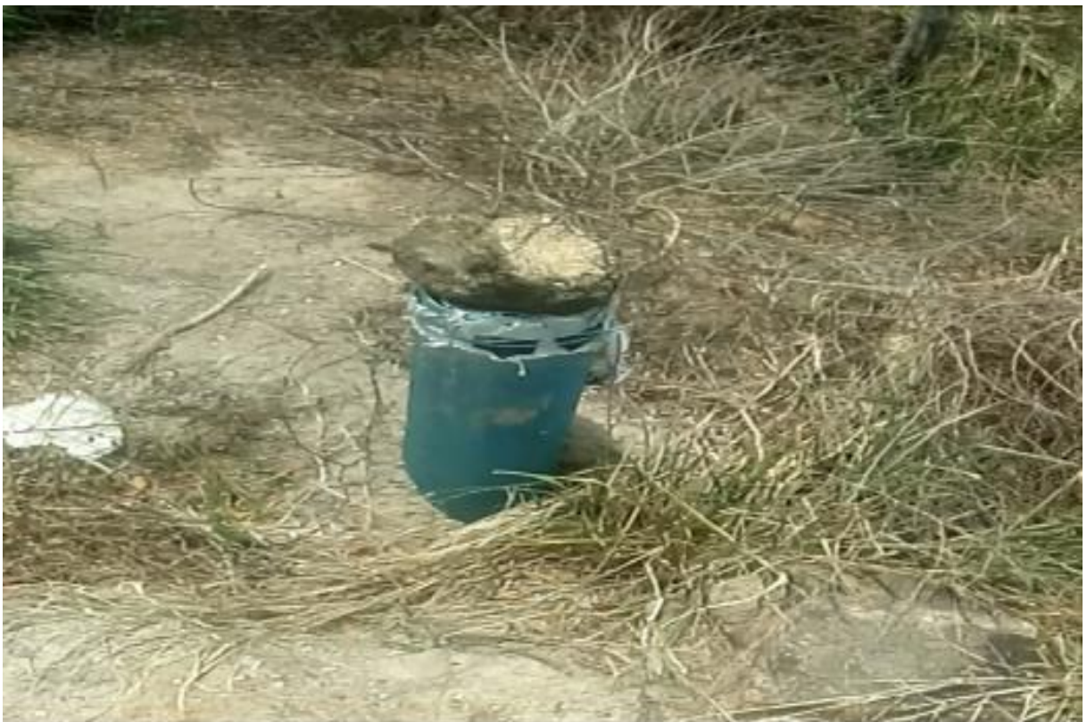
Figura 122 – Poço Subterrâneo em Instalação Sítio Jardim Fonte: INSTITUTO GESOIS, 2021.
