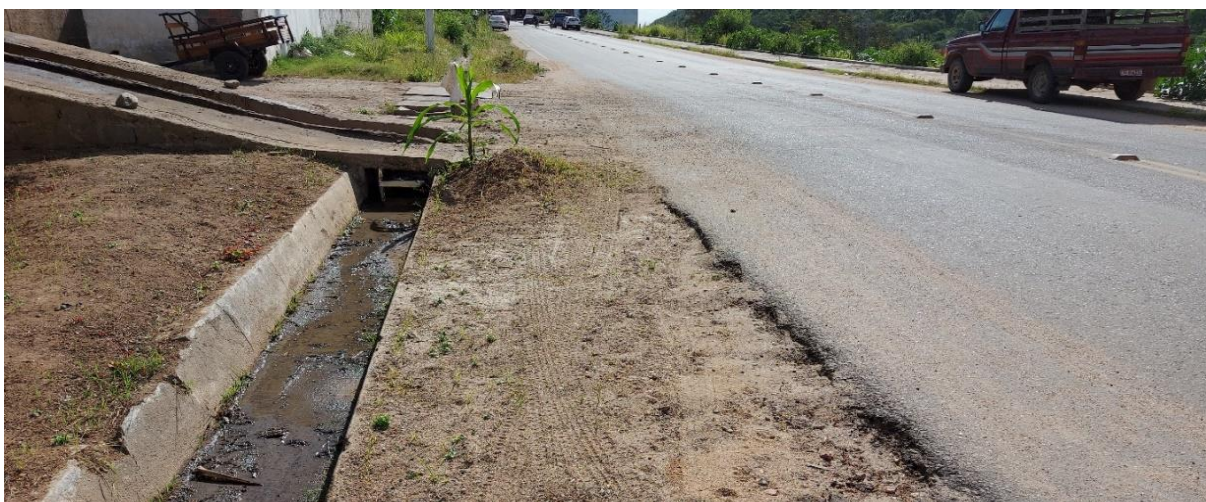
Figura 142 – Rua Pavimentada com Asfalto Sarjeta Drenando a Água Fonte: INSTITUTO GESOIS, 2020.
