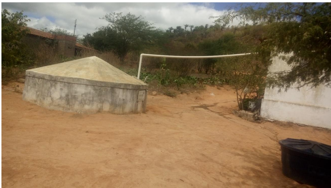
Figura 73 – Cisterna para Captação da Água de Chuva e Armazenamento de Água Trazida por Carro-Pipa Fonte: INSTITUTO GESOIS, 2021.
