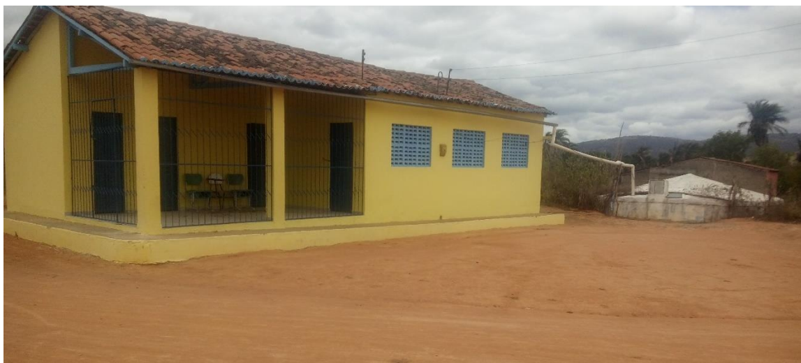
Figura 67 – Escola Municipal e Cisterna para Captação de Água da Chuva e Armazenamento de Água Trazida por Carro-Pipa na Localidade de Covões Fonte: INSTITUTO GESOIS, 2021.
