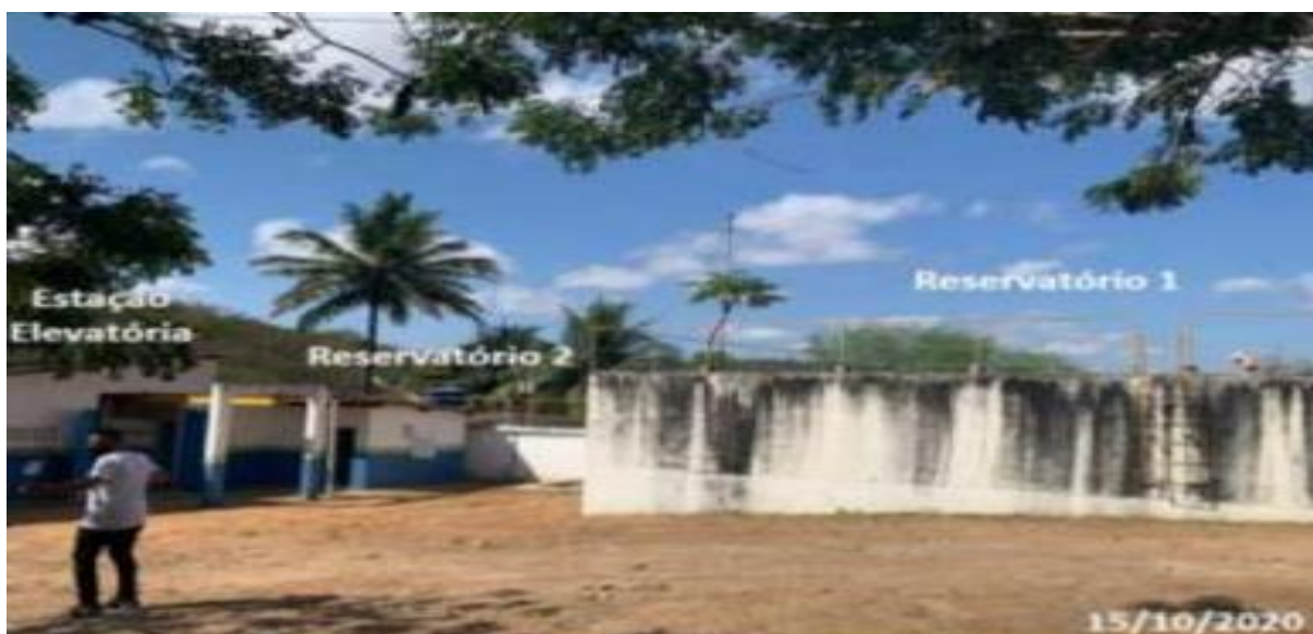
Figura 28 – Reservatório 1 EEAT-04 de Água Branca Fonte: ARSAL, 2020.
