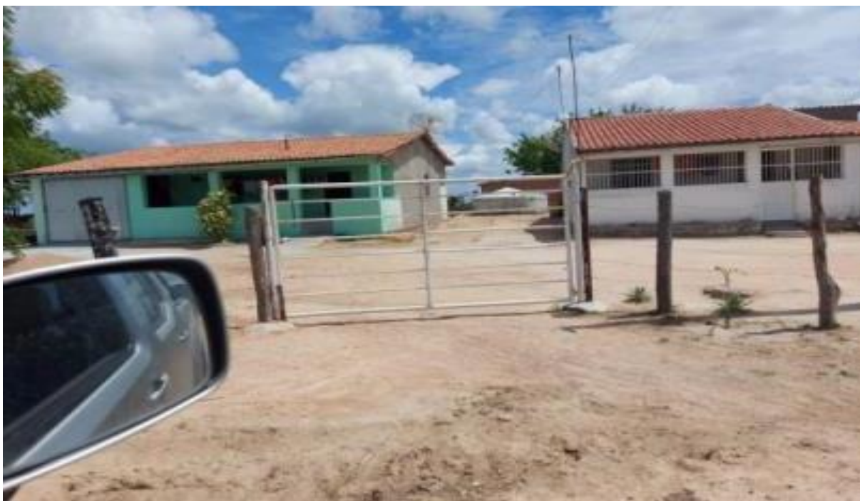
Figura 84 – Vista da Comunidade com Cisternas Localidade Lagoa do Caminho/Favela
