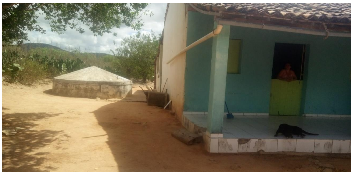
Figura 70 – Cisterna para Captação de Água de Chuva e Armazenamento de Água Trazida por Carro-Pipa na Comunidade Lagoa do Feijão
