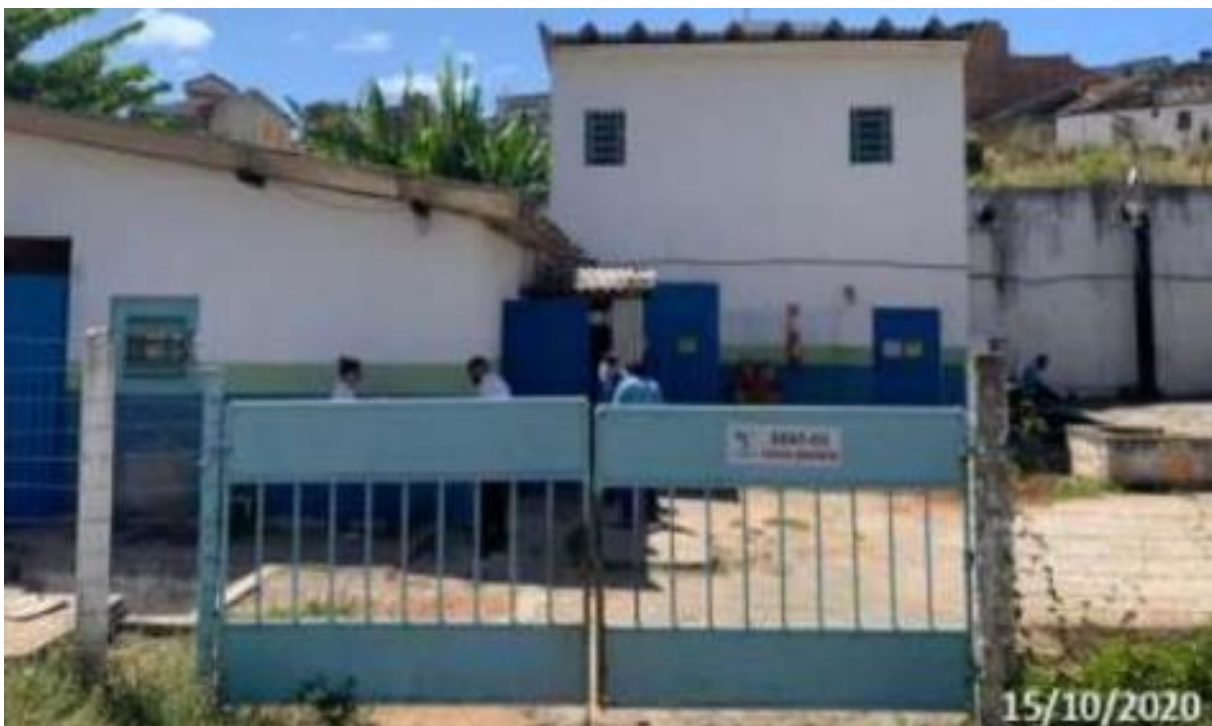
Figura 26 – EEAT- 05 de Água Branca Fonte: ARSAL, 2020.
