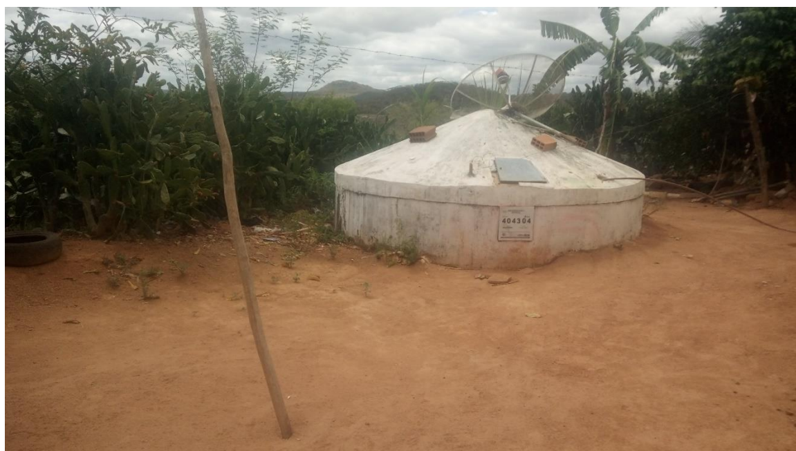
Figura 72 – Cisterna para Captação de Água da Chuva e Armazenamento de Água Trazida por Carro-Pipa na Comunidade Mucunã Fonte: INSTITUTO GESOIS, 2021.
