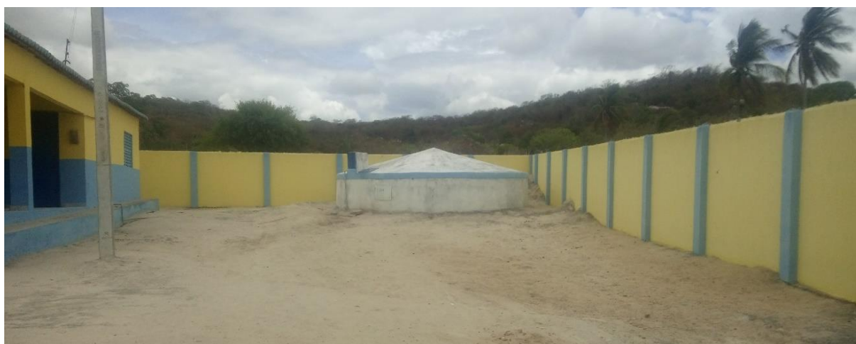
Figura 110 – Cisterna para Captação de Água da Chuva e Armazenamento de Água Trazida por Carro-Pipa na Comunidade Saco dos Pampus
